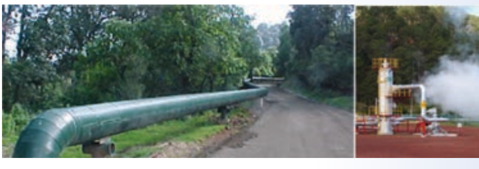
Figura 15 Línea de conducción y cabeza de pozo en campos geotérmicos mexicanos 20
