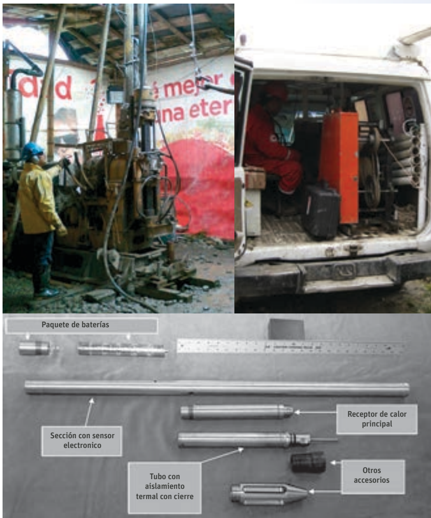
Figura 28 Perforación de pozos de gradiente térmico en el macizo Volcánico del Ruiz 36
